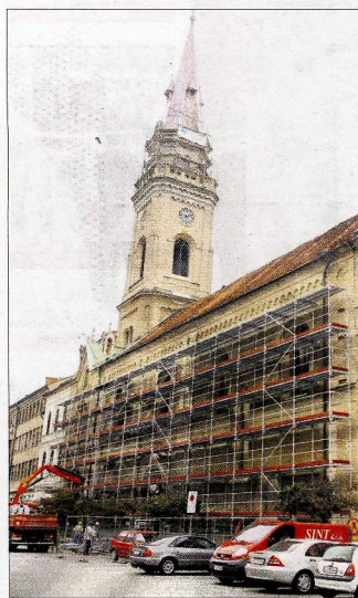
Še eno gradbišče v Celju, ki ga bomo opazovali v prihodnjih mesecih. Na vrstici celovita obnova zunanjsčine Marijine cerkve.
