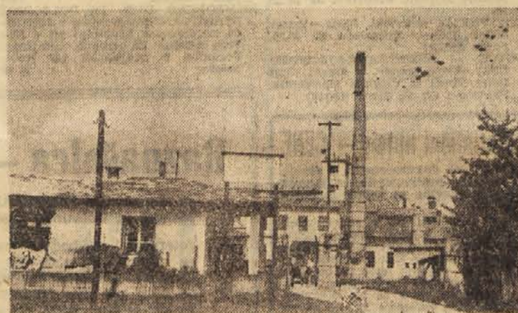
»Sončnica« — tovarna jedilnega in tehničnega olja proizvaja mesečno 140 ton jedilnega olja iz rašide, sončnice in oljne repice. Glavni problem: nimajo zadosti rezervoarjev za jedilno olje, rafinerija pa dela zaradi ozkega grla stiskalnice le s 50 odstotno kapaciteto
