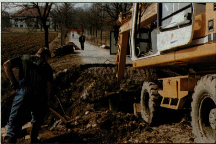
Zaradi gradnje novega mostu je cesta v drevoredu proti Žovneku zaprta.
