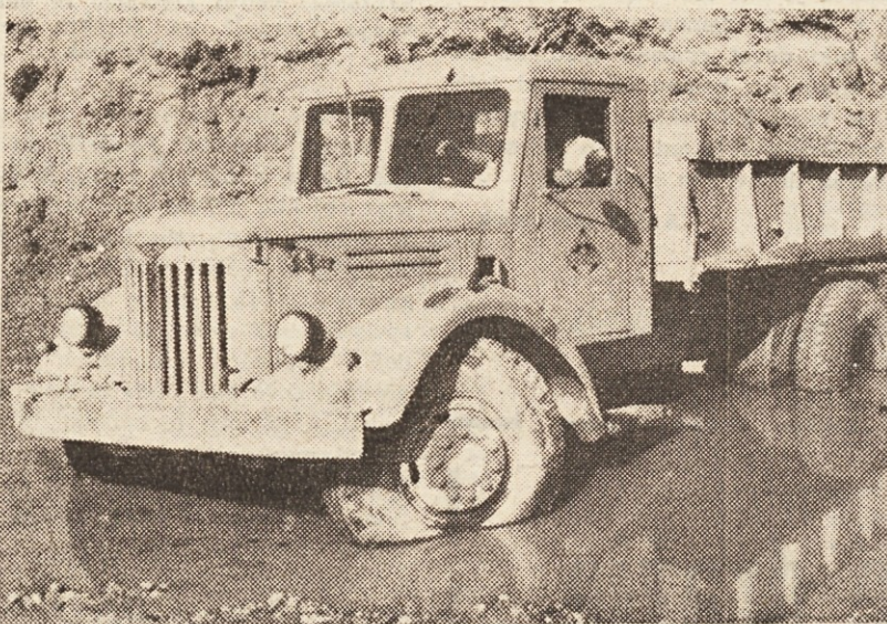
Izkop na srednji Dravi, zaradi vode in blata je izkop in odvoz zelo težaven
