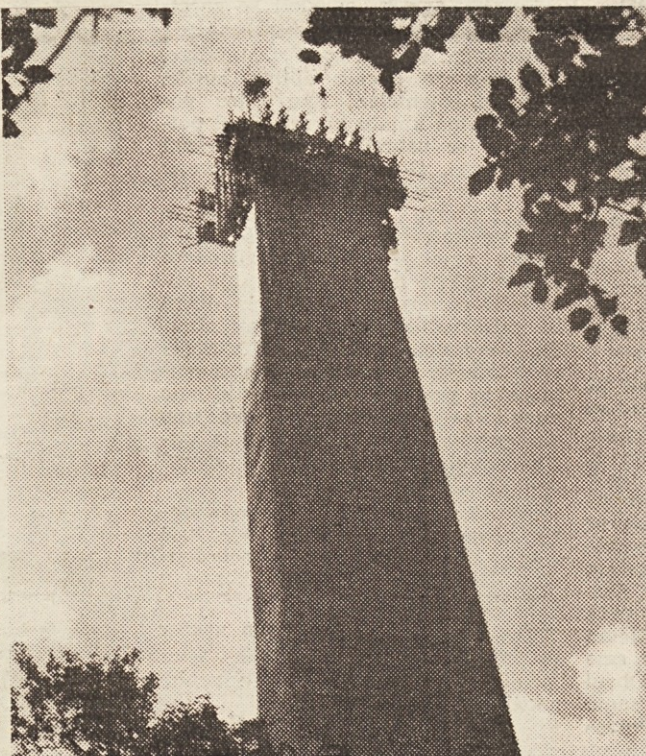
Ob pomoči skoraj vseh poslovnih enot napredujejo dela na ljubljanski toplarni dokaj po planu — Televizijski stolp? Ne, to je sedmi stebel velikega mostu čez Peračico na gorenjski cesti. Most bo dolg 376,45 m in bo stal na osmih stebrih, od katerih je največji visok 60 metrov. Gradi ga PE Ljubljana
