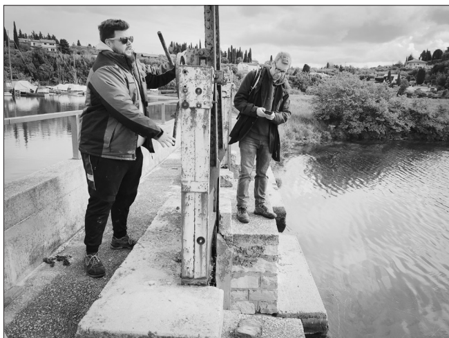
Vodar na »vratih« odpira glavno zapornico za dovod morske vode v kanal Lera (foto: Maja Bjelica, 26. 4. 2024).
