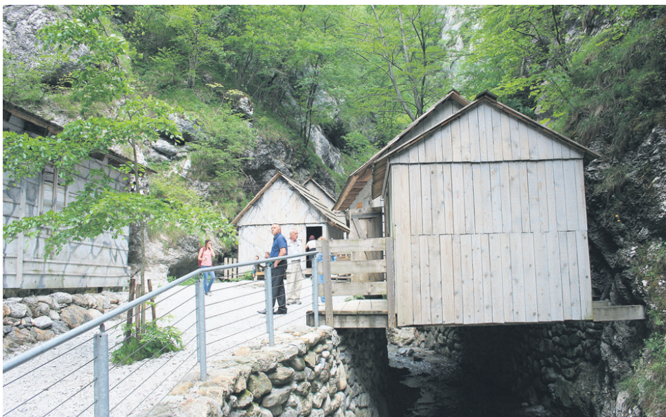
V 14 barakah so bili za ranjence operacijska soba, izolirnica, baraka za rentgen, soba za zdravnike, baraka za osebje, invalidski dom, skladišče za hrano, kuhinja, pralnica, kopalnica, mizarska delavnica in celo električna centrala.
