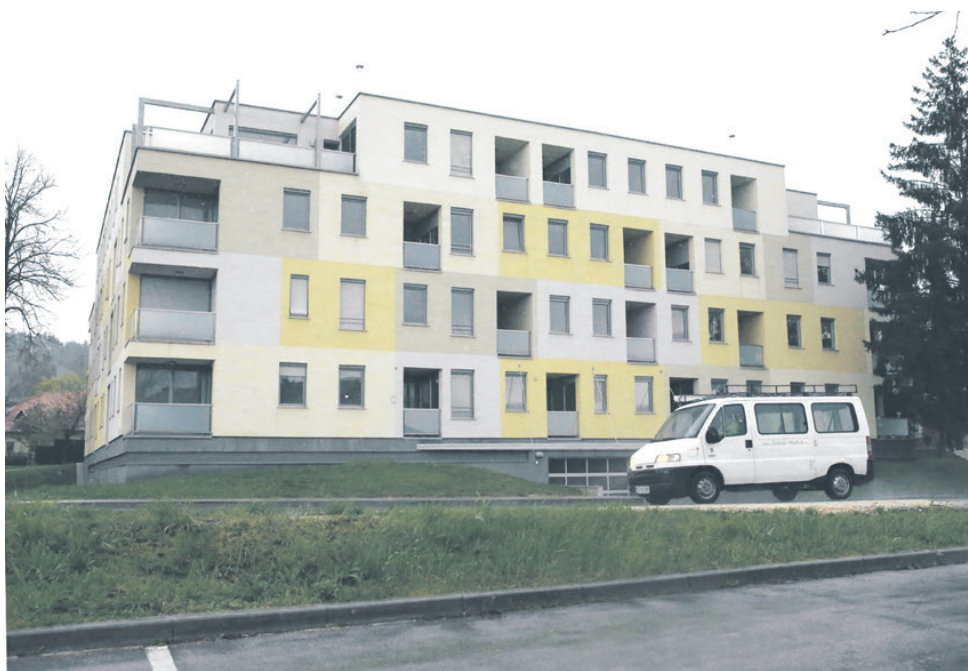
Ima slaba banka resnega kupca za nakup novega bloka v Vojniku? Odkar je graditelj pred nekaj leti zašel v težave, blok propada.
