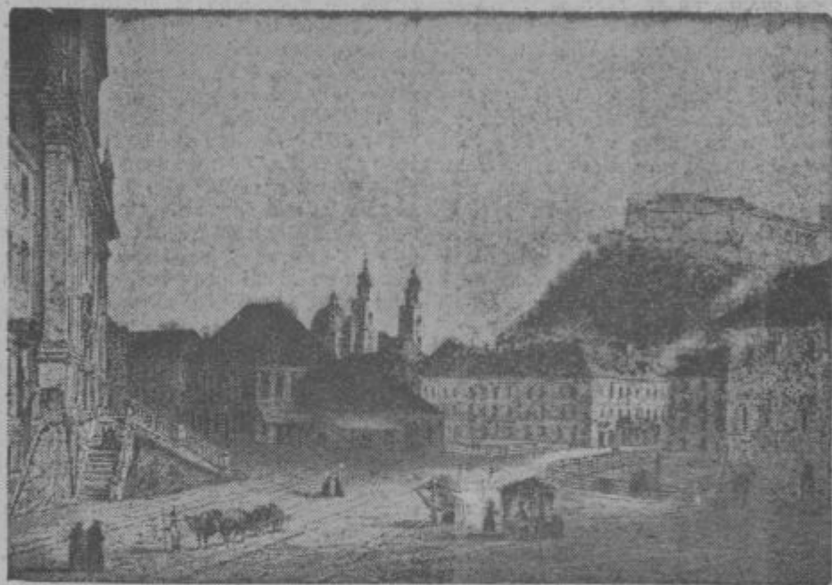
Pogled na špitalski (francišksanski) most, v ozadju na tevo stara Kresija, spredaj levo Bučarjeva trgovina in tik nje Mayerjeva lekarna. Vse tri hiše so bile porušene po potresu. Z odstranitvijo Bučarjeve hiše je bila šele dosežena zveza na Sv. Petra nasip.
