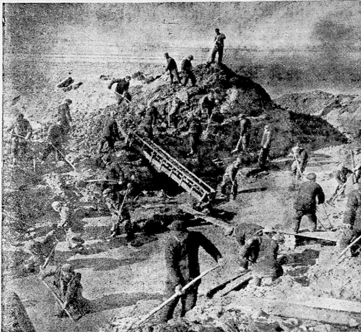
V pokrajini Hebei pri izkopu kanalov za namakanje
