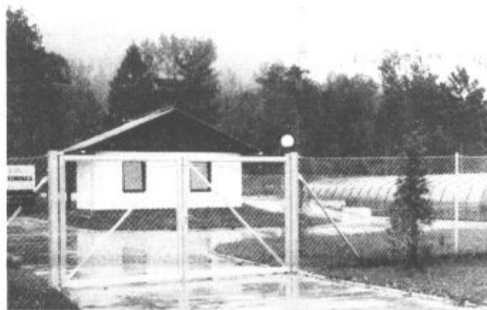
Čistilna naprava v Lokah naj bi kmalu pričela obratovati
