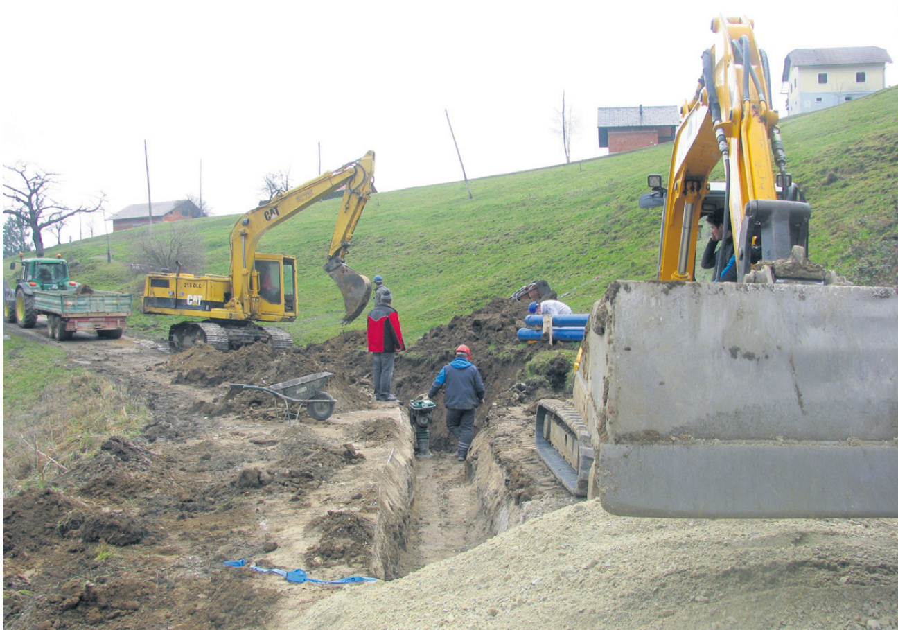
Cevovod iz vodohrana v Šentjanžu do naselja Šmarje je v 90 odstotkih že zgrajen. Objekti in cevovodi po drugih občinah so zgrajeni v različnih stopnjah.
