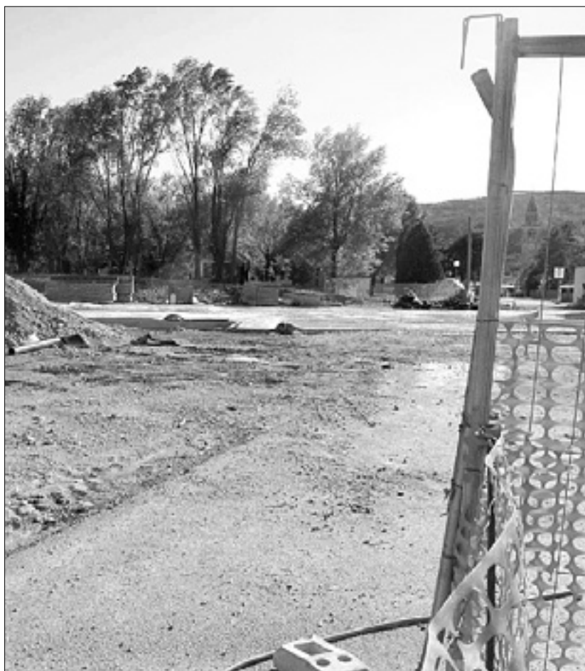
Gradbišče predora v Sovodnjah
