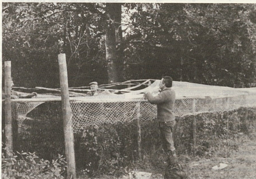
Gradnja prilagojevalne voljere ali letnega izpusta za osemtedenske fazančke, ki jo uredimo vedno v najboljšem delu lovišča
