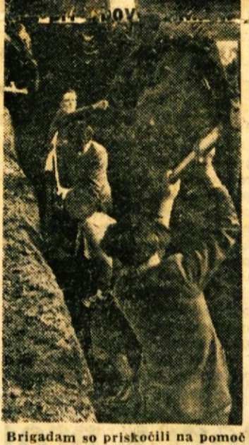
Brigadam so priskočili na pomoč tudi novomeski srednješolci in pomagal kopalni jarke za vodovod pri Ločni in Mačkovec. Njihova brigada bo šla na avto cesto šele poleti.
