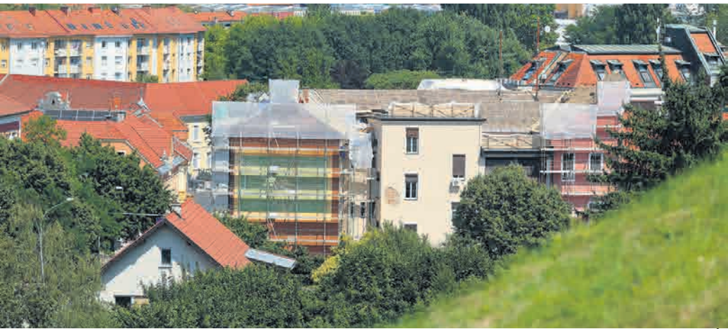
Foto: CG Gradbeni oder bo na pločniku ob UE Ptuj stal do jeseni. Naslednje leto bo država obnovila še fasado na dvoriščni strani objekta.
