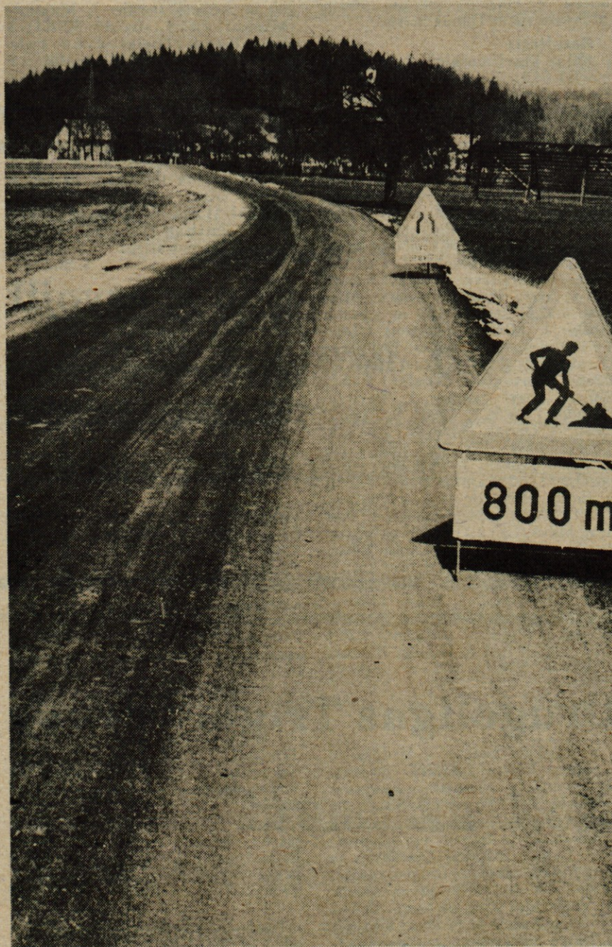
Cestno podjetje iz Kranja je minuli teden asfaltiralo okrog tri kilometre dolg odsek ceste od Podvina do Zapuž v radovljiški občini. Asfaltna prevleka je široka štiri metre in pol, na vsaki strani pa bo cesta imela še okrog pol metra bankine, ki jih pravkar urejajo. Denar za asfaltiranje te ceste, katere del bi moral biti po pogodbi gotov že lani, je zagotovila radovljiška občinska skupščina. — A. Ž. — Foto: F. Perdan
