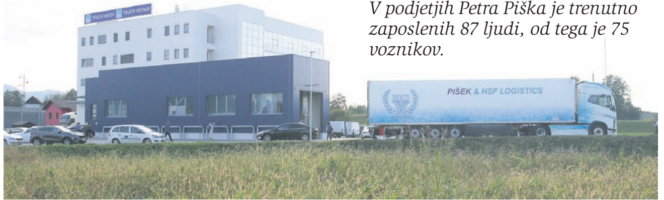
Družba Pišek – HSF Logistics je na Lopati zgradila 850 kvadratnih metrov skladišč za zamrznjena živila, servisno delavnico in pralnico za tovarnjake, parkirišče, poslovne prostore ter stanovanja za voznike.
