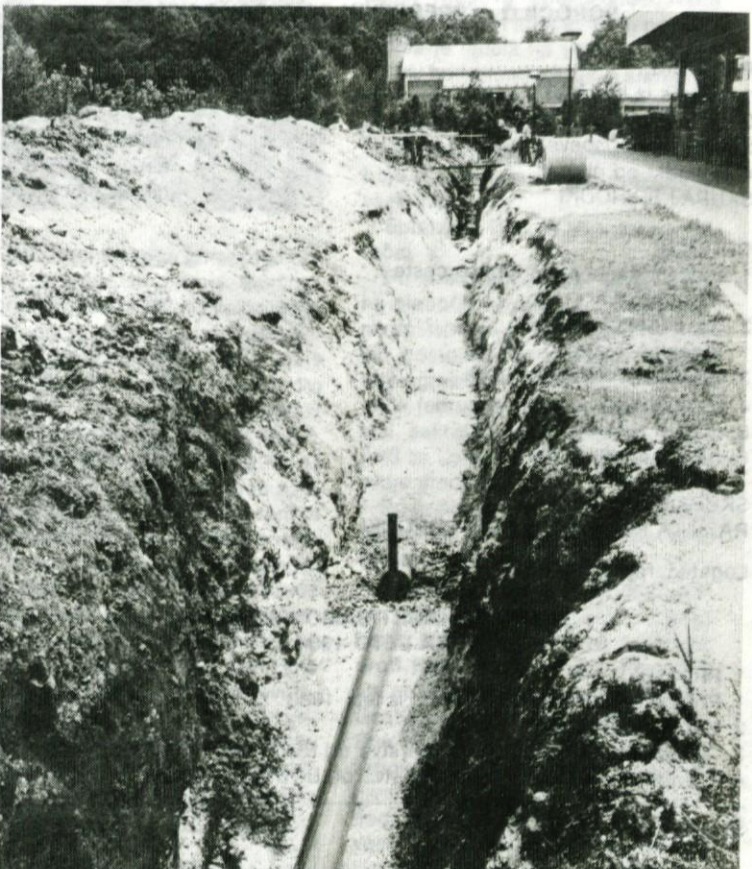
»Začetni metri H – kanala pri Valkartonu« (Foto: Maš)
