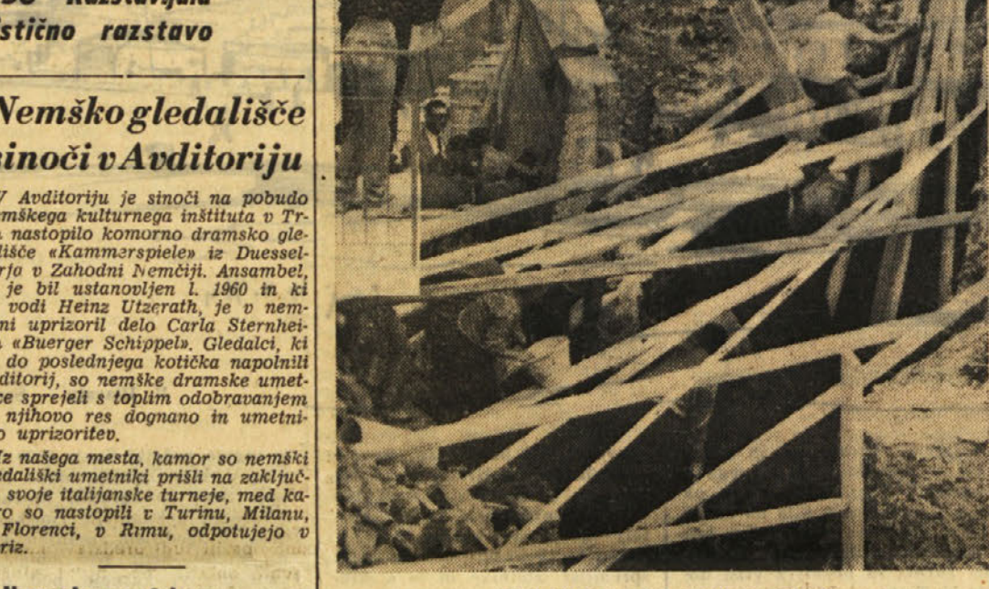
Med izkopavanjem zasutega delavca
