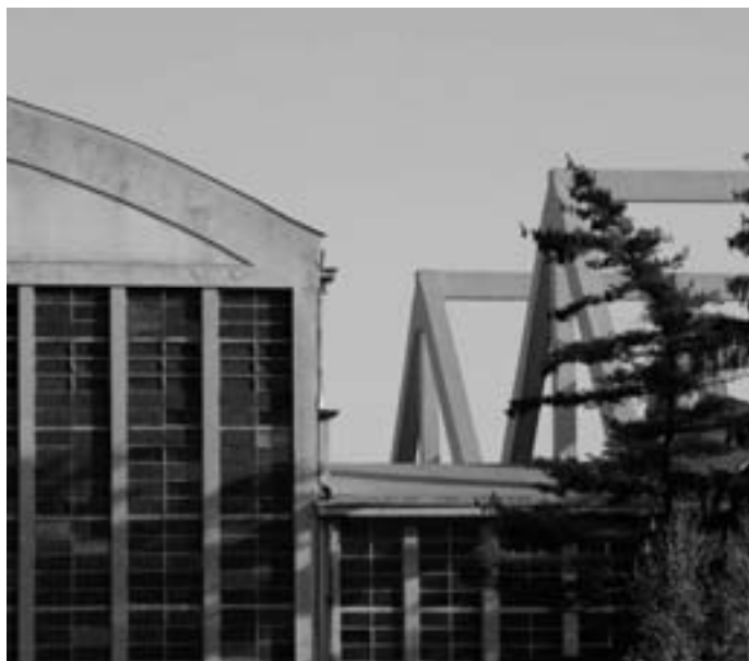
Slika 2: Objekt obdelovalnice v Litostroju je primer inovativne konstrukcijske zasnove. Obešeno streho na armiranobetonskih zunanjih vešalih je leta 1946 zasnoval Miroslav Gregorič. Foto: Miran Kambič.
