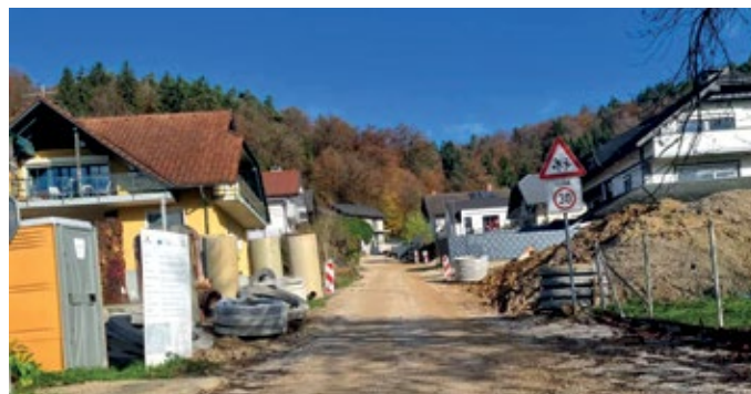
»Novi Utik« – gradnja kanalizacije in druge komunalne infrastrukture, delno z evropskimi sredstvi.
