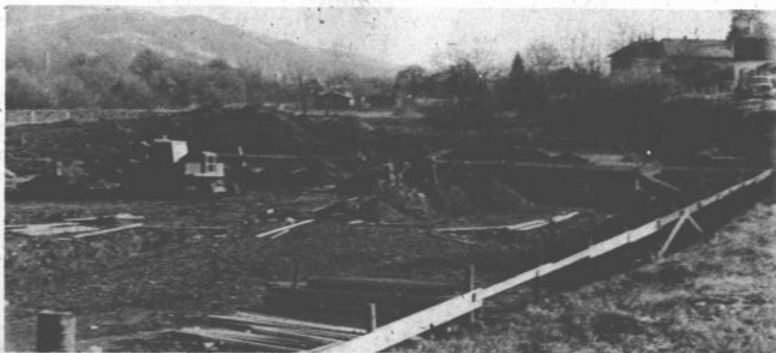
Na prostoru v neposredni bližini nogometnega igrišča so začeli z zemeljskimi deli pri gradnji športne hale, ki naj bi bila do III. faze zgrajena v letu 1975
