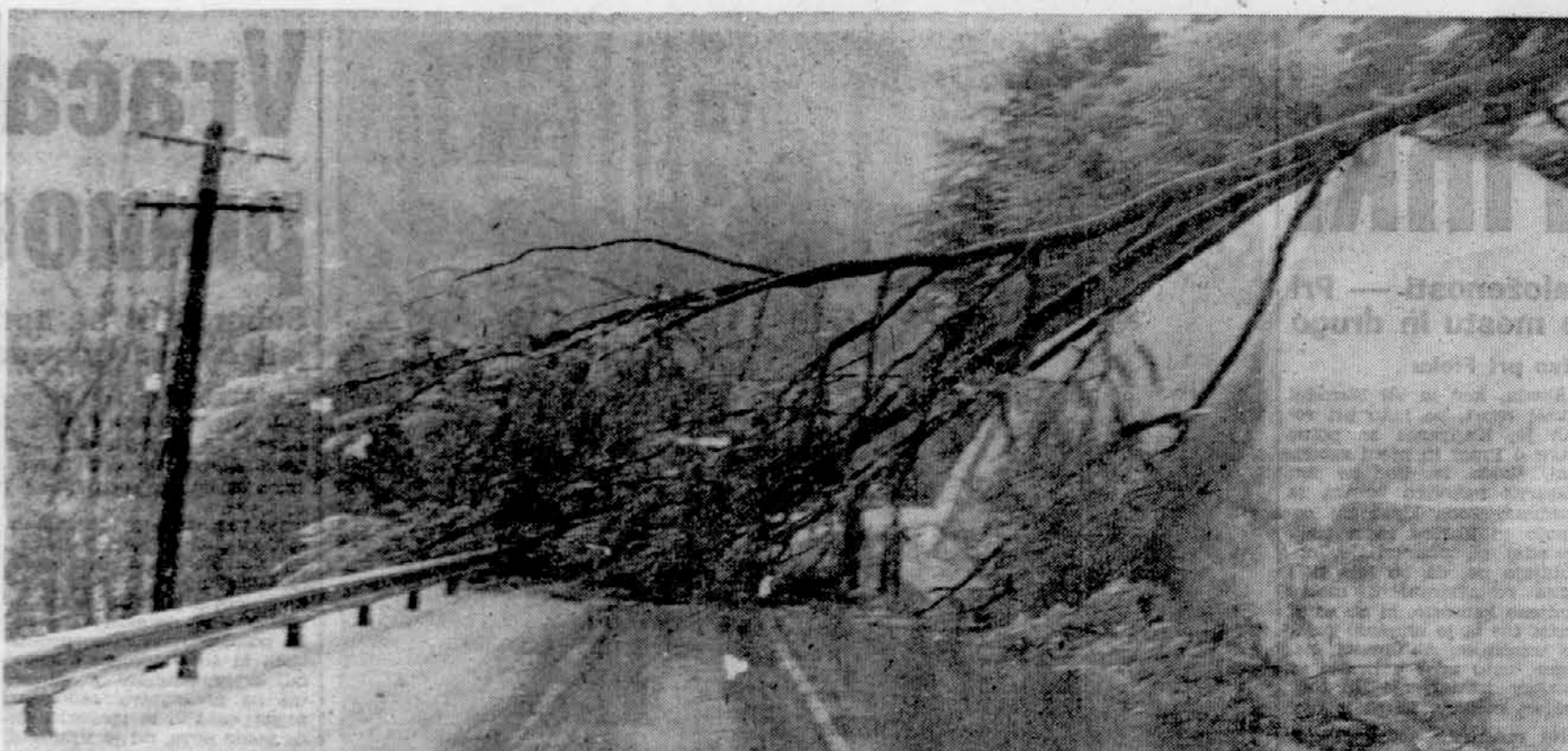
ZAVESA ČEZ CESTO — V noči od nedelje na ponedeljek je neurje poskrbelo za takole neprebrano zaveso na novem odseku bohinjske ceste blizu Soteske. Močno deževje je na slabo izdelanem nasipu izpodkopal in prineslo po nasipu veliko drevo, ki se je prevrnilo čez cesto in z vrhom seglo celo na železniško progo. Potrgalo je telefonske zveze in za več ur zaprl promet. Le manjši avtomobili so si skozi majhno luknjo utirali pot naprej. Foto: Janko Rozman
