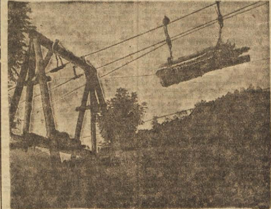
Spravilo lesa je po gozdnih žičnicah hitreje in ceneje
