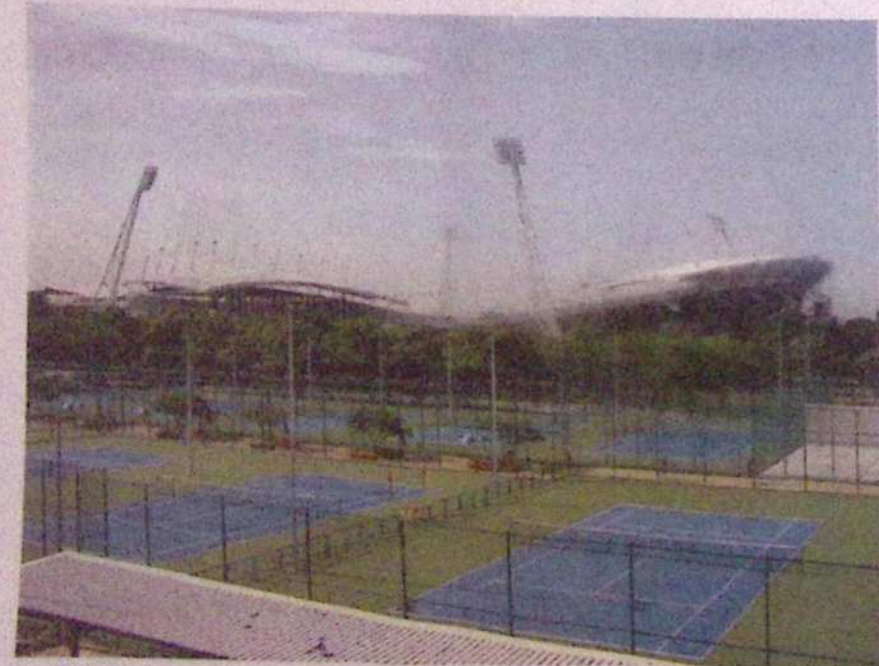
Pogled iz sobe na glavni stadion
