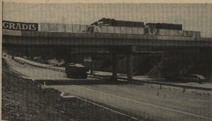
Delavci ZRMK opravljajo meritve med obremenilnim preizkusom objekta v Cikavi. Zraven novega nadvoza so še vidni ostanki starega.
