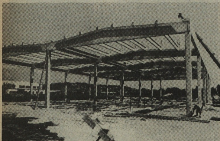
Dvoladijsko halo so delavci Gradbene enote Maribor zmontirali v nekaj dnevih. V njej bodo dobili prostor Certusovi avtobusi. Ostala dela bodo opravile ptujске Gradnje.
