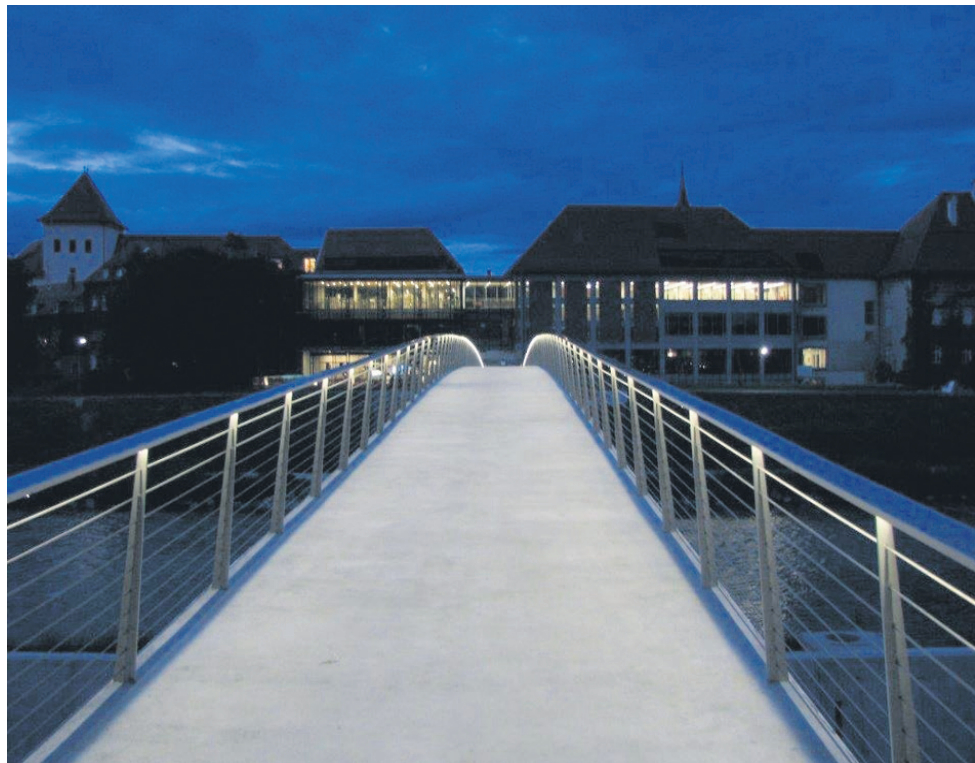
Razsvetljava na novi Splavarski brvi je vgrajena v varovalno ograjo, zato je pogled nanjo še posebej lep ponoči.
