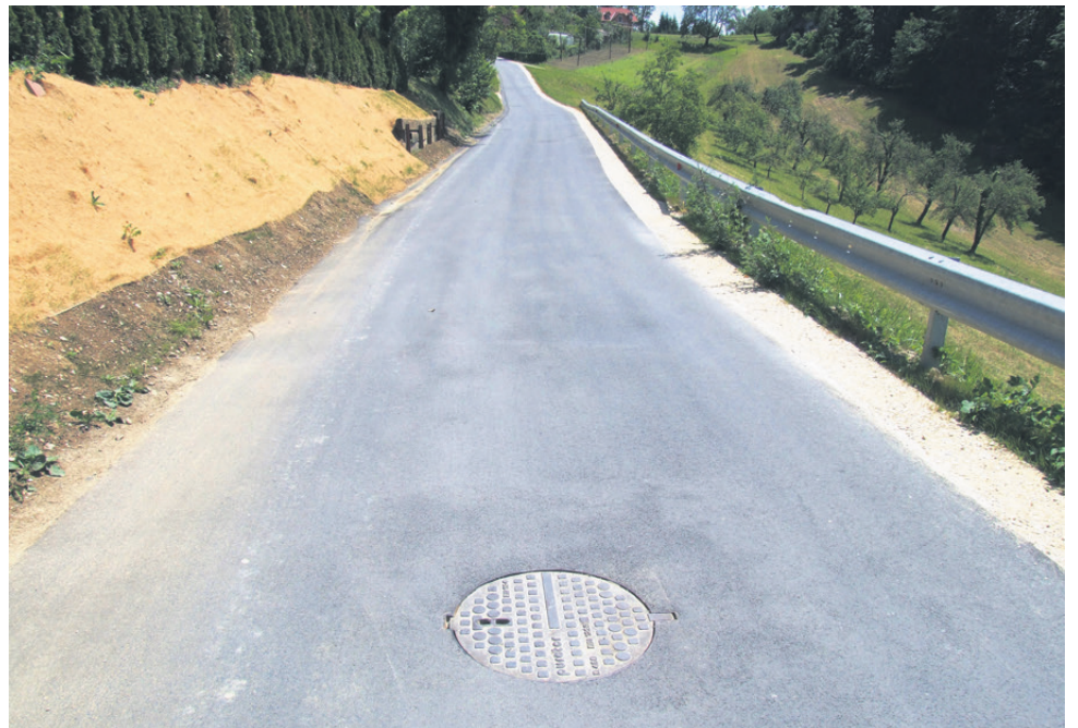
Gradnja kanalizacijskega omrežja v Zgornjem Šaleku
