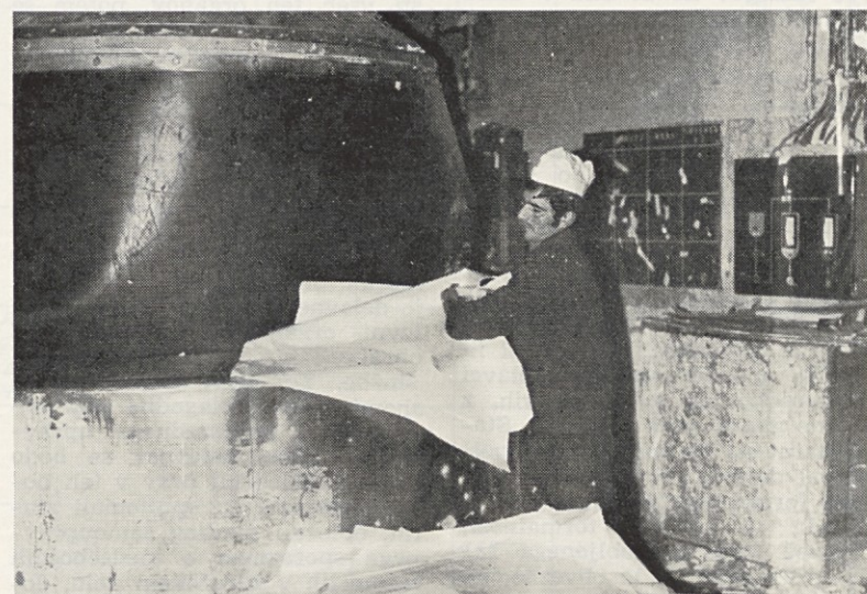
Vnos izmeta v pulper v oddelku strojne dodelave
