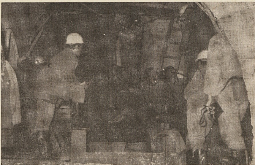
Montaža transportne mehanizacije v jami Kotredež. Dela izvajajo člani kolektiva TOZD RESD Zagorje. (Foto: L. Vozelj)
