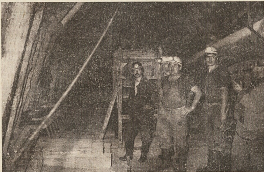
Priprava na izdelavo nadkopa N-73 v jami Kotredež.
