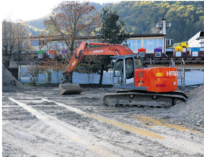
Med pomembnejše projekte v občini Laško sodi gradnja športne dvorane v Rimskih Toplicah. (Foto: Andraž Purg)
