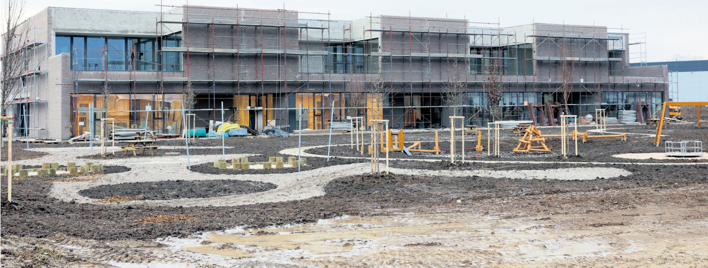
Zgradba novega vrtca v Žalcu je zrasla na podlagi javno-zasebnega partnerstva s podjetjem Esotech. V devetoddelčnem vrtcu bodo tudi razvojni oddelek, medgeneracijska dvorana in kuhinja, ki bo dovolj zmogljiva, da bo obroke lahko pripravljala tudi za zunanje stranke. (Foto: Andraž Purg)
