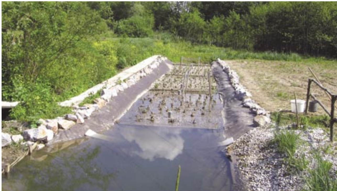
Slika 2: ERM – Prototip zasajenega jarka v Podutiku po izgradnji leta 2006 (foto: Tjaša G. Bulc).
