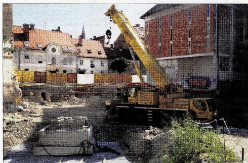
Staromska kloaka (na betonskem podstavku) iz 1. stoletja našega štetja je zdaj na varnem in čaka, da jo bodo po izgradnji prizidka k knjižnici postavili na mesto najbde.
