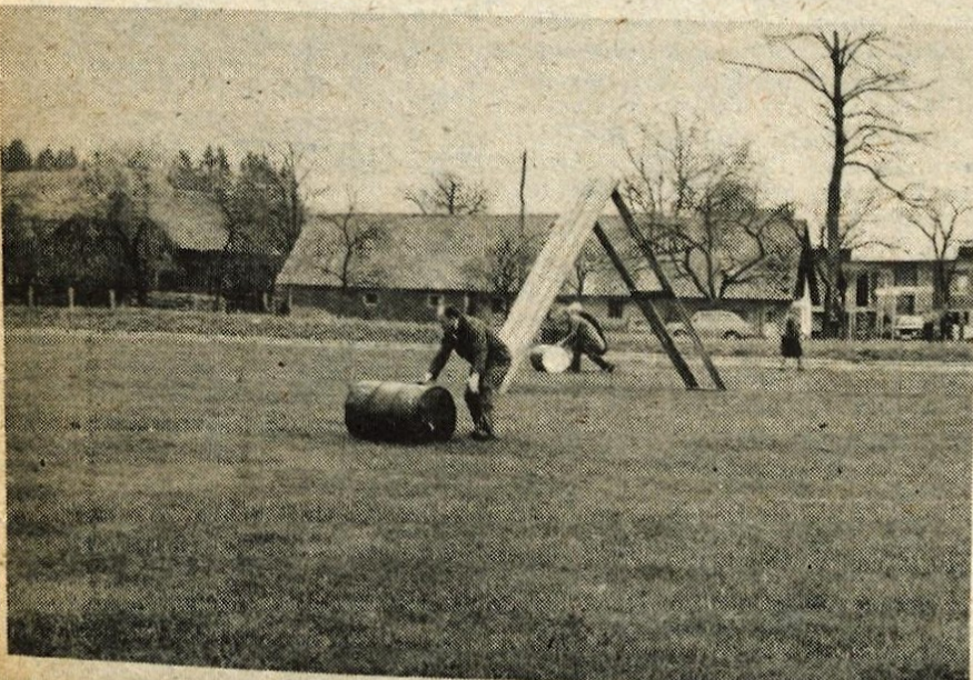
Ko se je nevarnost zračnega napada in desanta povečala, so področje dodatno zavarovali z ovirami, sodovi, posebnimi minami, pritrjenimi na deske, ki jih dvigne piš helikopterja ter s tem sproži mine, cevi, koli itd.
