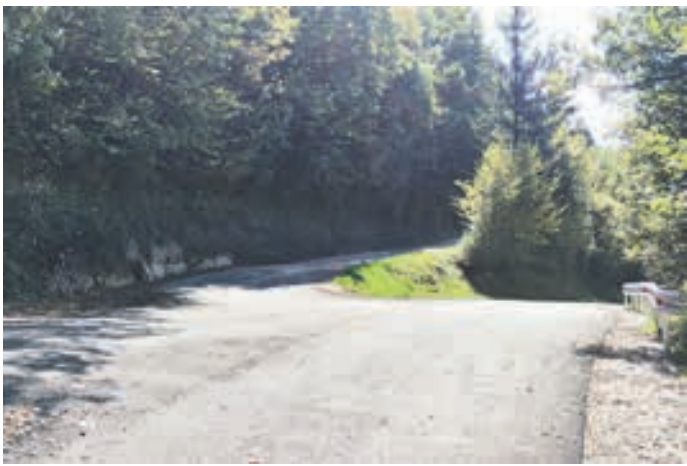
Prenovljeno križišče na cesti na Staro progo - foto A. Klemenc
