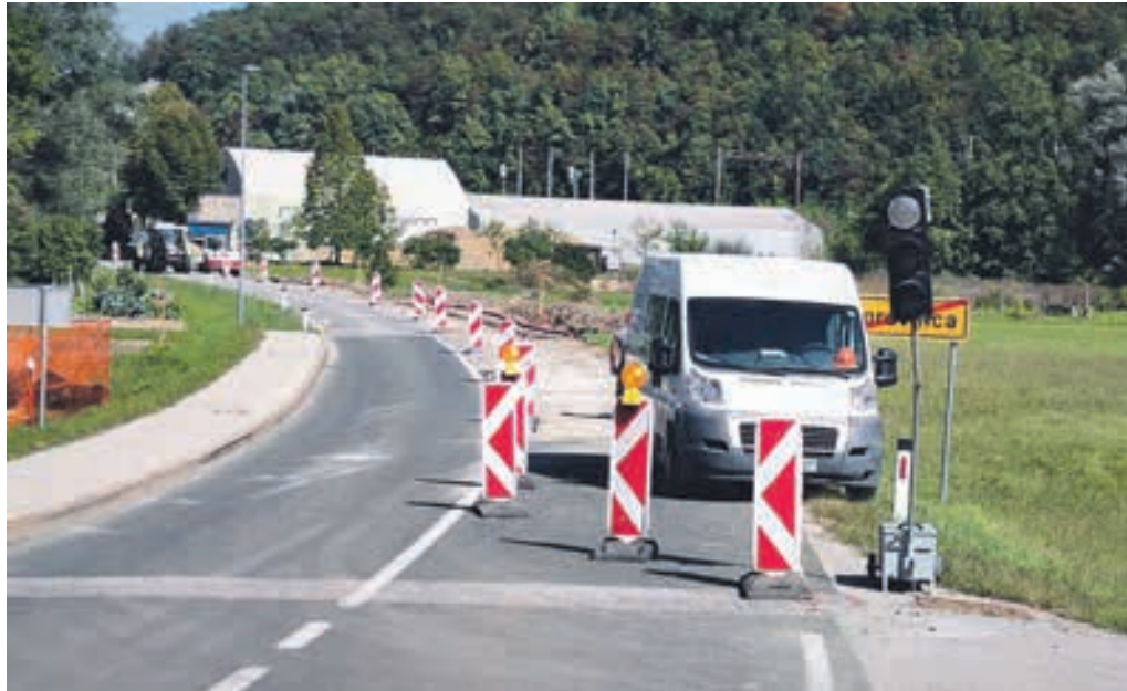
Gradbišče kolesarske povezave Borovnica - Breg - foto A. Klemenc
