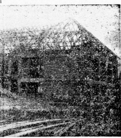
Gradnja ljudske šole v Mostah pri Kamniku
