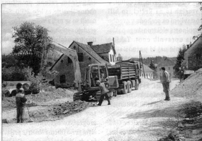
Dela na cesti skozi Spodnji trg v Gornjem Gradu intenzivno potekajo (foto: Ciril Sem)
