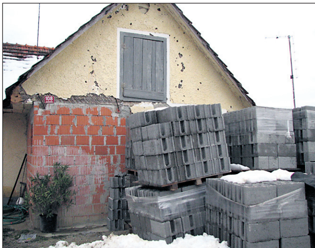
Dokumentacija za začetek novogradnje je že skoraj v celoti pripravljena, ob stari hiši pa tudi že čakajo zidaki za klet.
