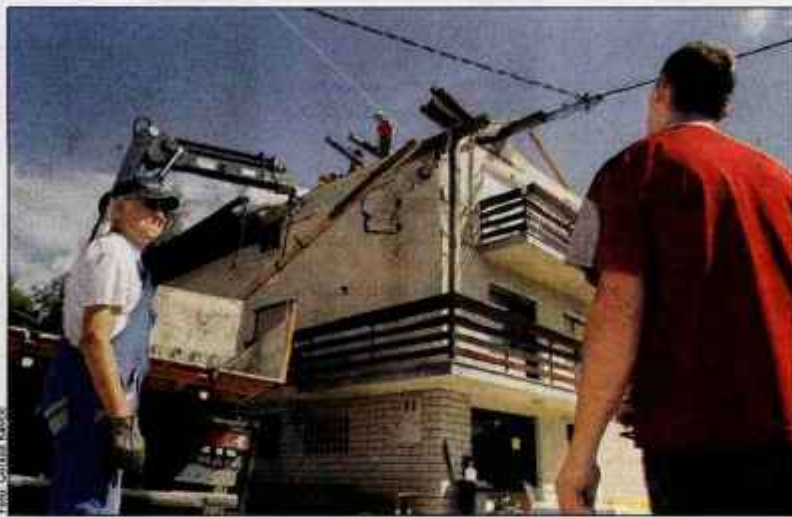
Na večini odkritih hiš na Gozdu so minuli konec tedna že postavljali nova lesena ostrešja.
