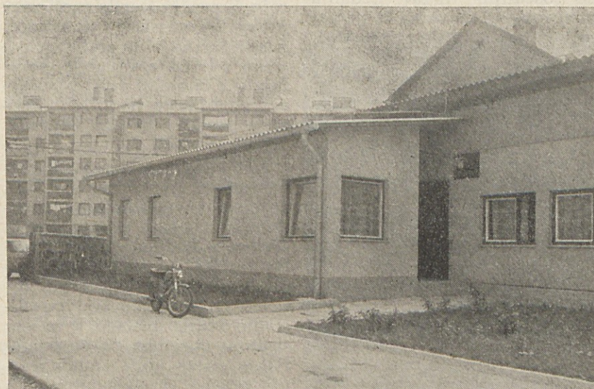
Pred nedavnim so delavci TOZD GRAMAT dobili v prizidku svoje upravne zgradbe nove sanitarije, sejno sobo in drugo.
