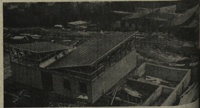
Postavljen montažni objekt čaka gradbene skupine, da ga oblečejo
