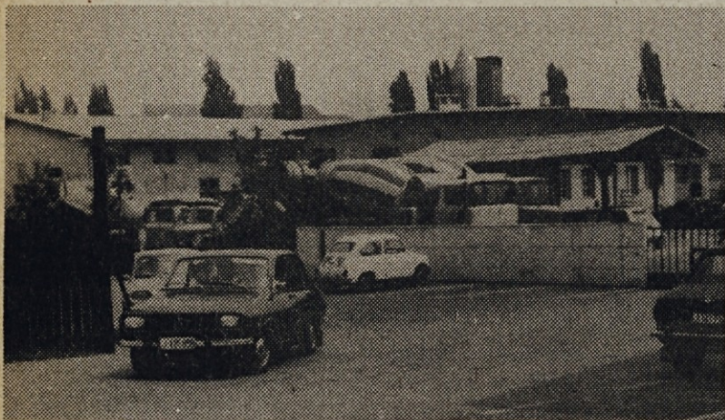
Sodobna tehnologija rabi tudi sodobne stroje med katerimi so tudi prevozni mešalci za dostavo kvalitetnega betona
