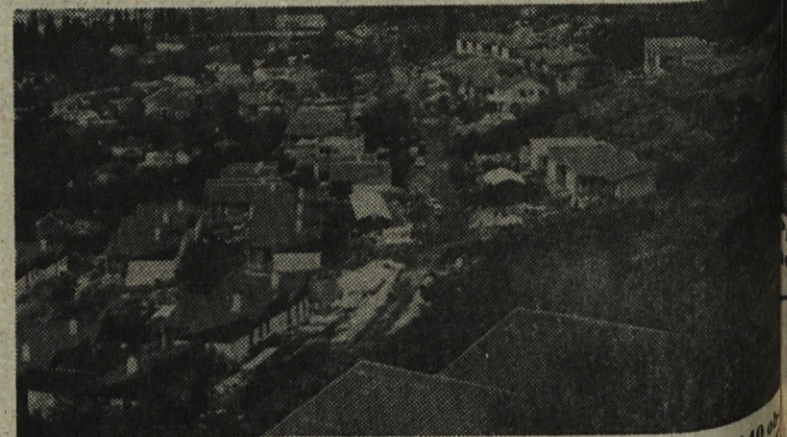
Naselje za kotorčane, ki jih je prizadejal potres. V Kotoru bo skupaj 140 objektov montažne proizvodnje, izvajalci pa so TOZD LIO Škofja Loka in GE Jesenice
