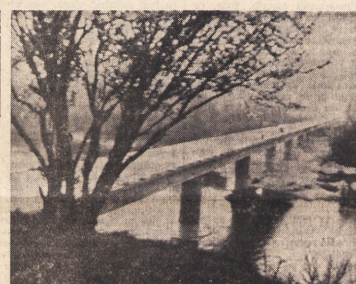
Več sto metrov dolg most čez Sočo med gradnjo
