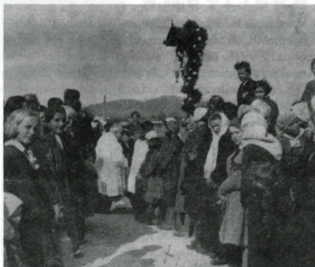
Postavitev križa na mostu čez Logaščico pred 2. svetovno vojno
