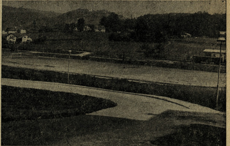
Obnavljanje starega športnega igrišča
