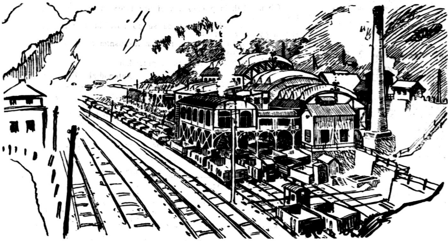
Trboveljska separacija, kjer izpirajo premog in ga potem nakladajo v vagonce, je izmed vseh separacij v državi najmoderneje urejena. Dnevno odpošljejo tu po več sto vagonov premoga. Njegova vrednost znaša letno okoli 150 milijonov dinarjev.
