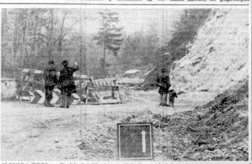
ILOVICA DRSI — Prebivalci Planine pod Golico ogledujejo, kako potekajo dela pri graditvi ceste. Posebno jih zanima odsek, kjer drsi ilovica z Mirce proti grapi Jesenice.
