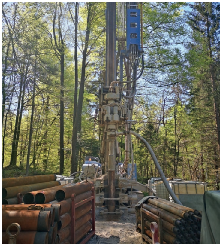
Začetek vrtalnih del na vrtini 7 na Golem
