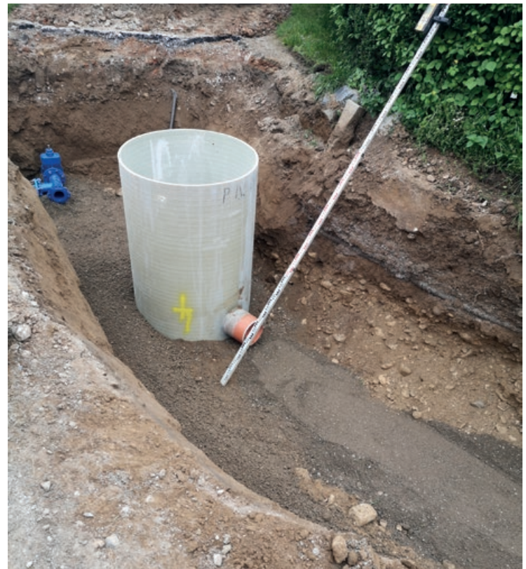
Izgradnja kanalizacije in obnova vodovoda v Iški Katja Ivanuš
