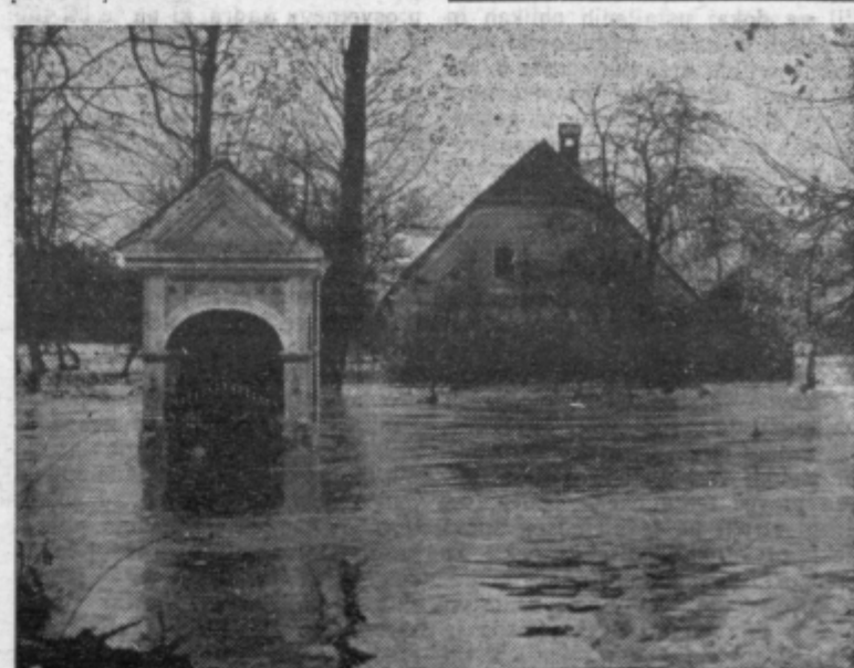
Na sliki: Poplavljenost stanovanjske poslopje med lansko jesensko poplavo
