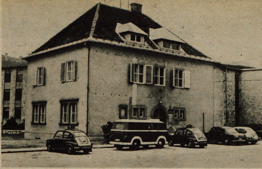
V petek, 28. decembra, so slovesno izročili kranjskim miličnikom preurejeno stavbo v Stritarjevi ulici 6. V hiši je 300 kvadratnih metrov delovne površine. V pritličju so delovni prostori, v nadstropju pa so uredili tudi tri samske sobe za miličnike in čajno kuhinjo. — Foto: F. Perdan
