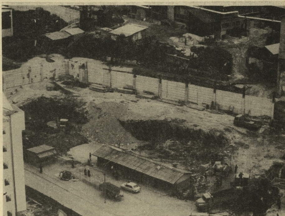
Dela pri gradnji novih delavniških prostorov na rudniku Hrastnik počasi, vendar vztrajno napredujejo. (foto: B. Klančar)
