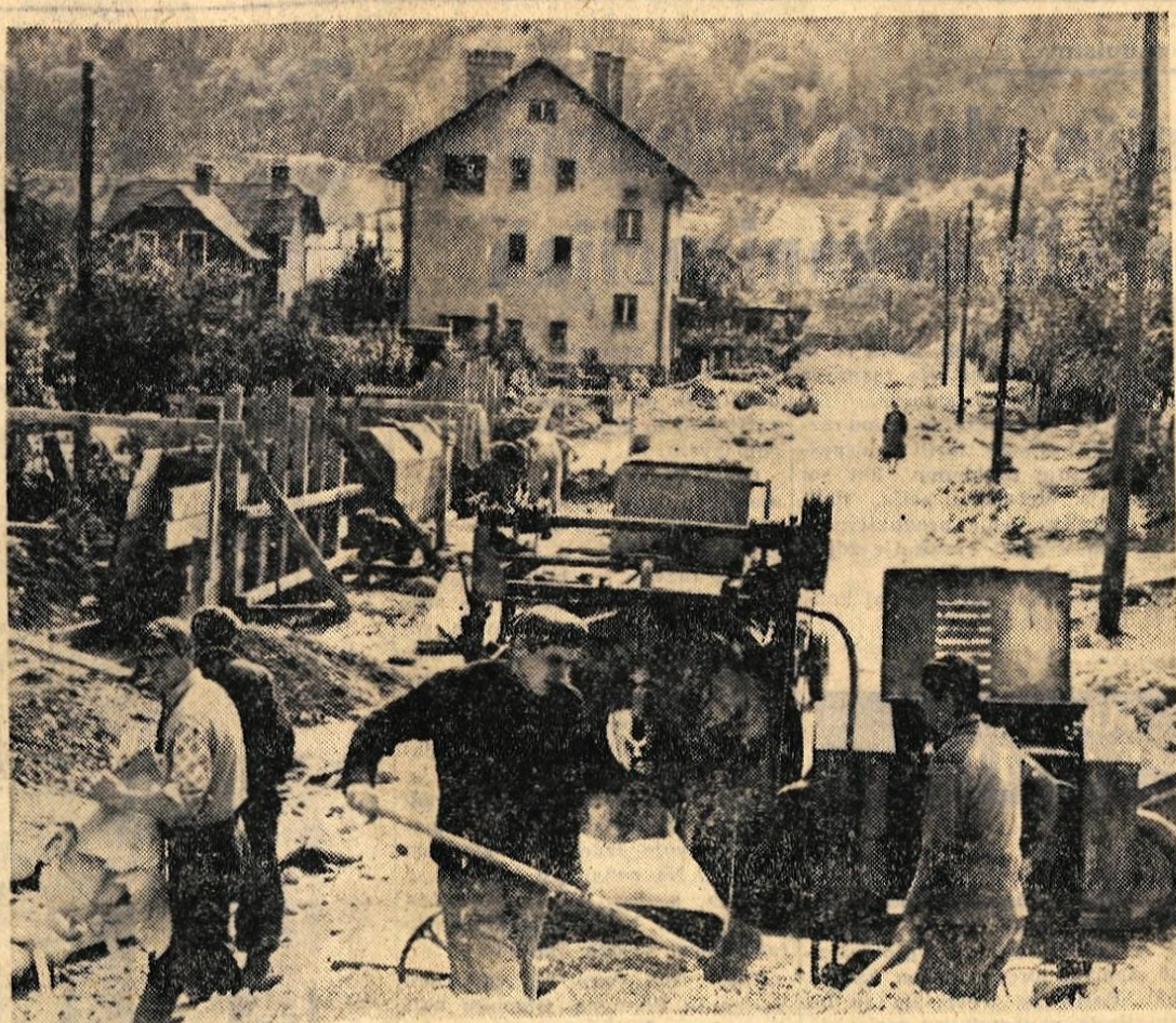
Potem ko so zgradili most čez Savo, ki bo povezoval Javornik z Blejsko Dobravo, so te dni začeli tudi za gradnjo odcepa ceste. Ta bo povezoval cesto prvega reda Podkoren-Ljubljana in most čez Savo
