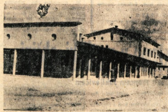
Prva na Dolenjskem je bila po zadnji vojni zgrajena železniška postaja v Metliki
